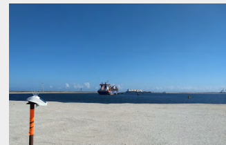
Ausbaggern im Hafen
